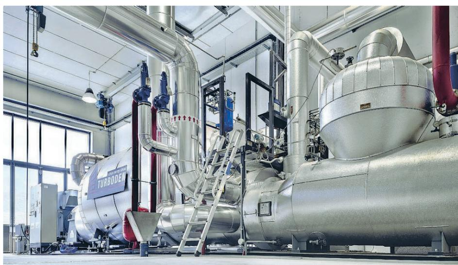
genera energia elettrica. Successivamente, in fase di condensazione del fluido, si genera vapore a media pressione. Una singola unità può fornire da 5 a 30 t/h di vapore, tra 4 e 30 bar, ed elettricità tra 600 kW e 4,5 MW.
